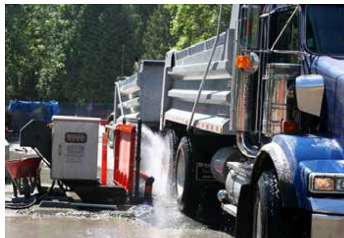
Mynd 3. Moldugar götur við framkvæmdasvæði í Reykjavík og dekkjapvottavél sem kemur í veg fyrir að jarðvegur frá svæðinu berist út í gatnakerfið.
