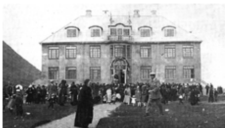
Vigsla sjúkrahússins á Ísafirði 17. júní 1925. (Arkitekt: Guðjón Samúelsson.) (Ljósmyndasafnið Ísafirði.)
