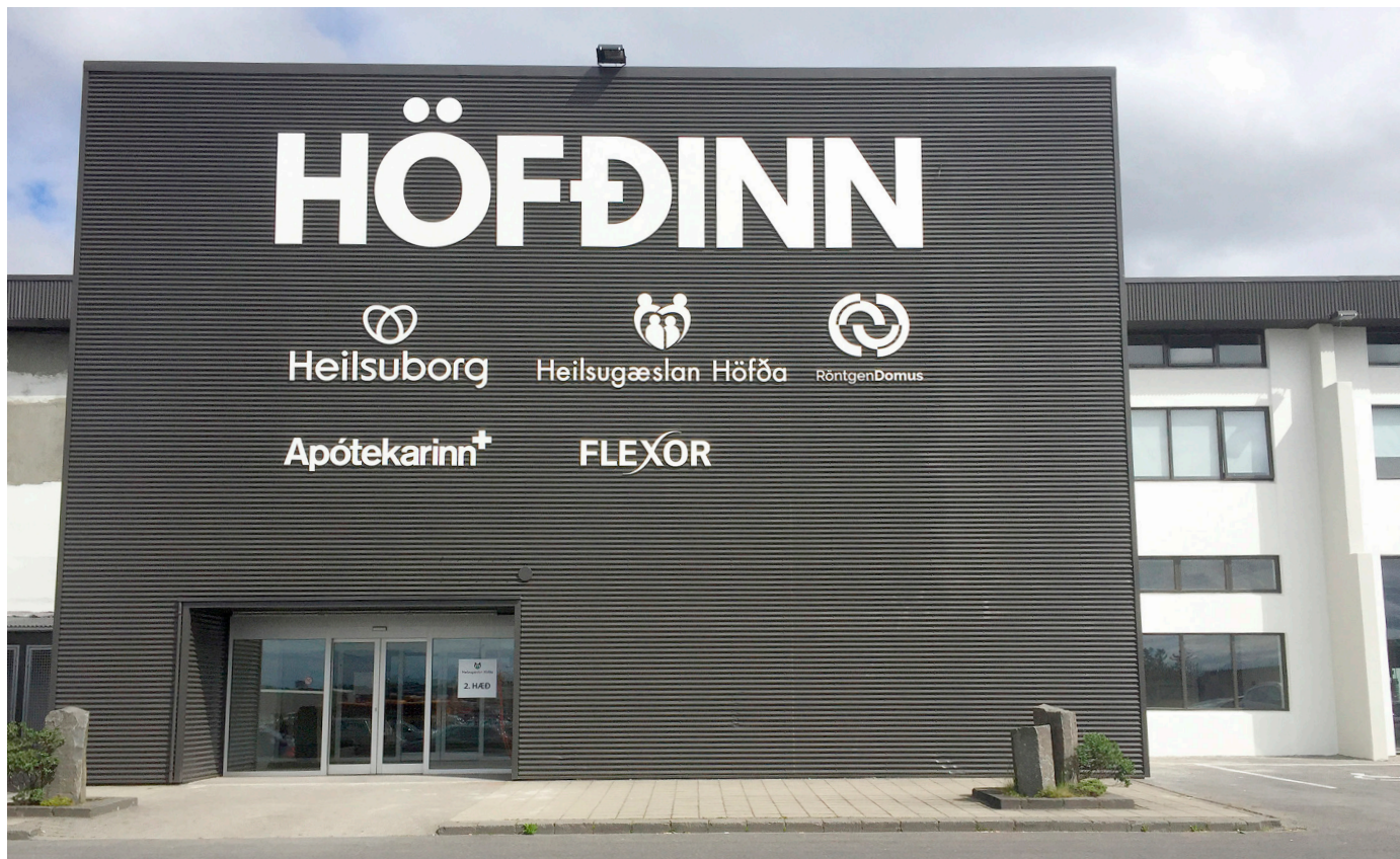
Svona lítur framhlið húss Heilsugæslunnar Höfða út. Stöðin er á 2. hæð hægra megin en vinstra megin á sömu hæð er verið að innrétta húsnæði Heilsuborgar og Röntgen Domus. - Mynd ÞH.
