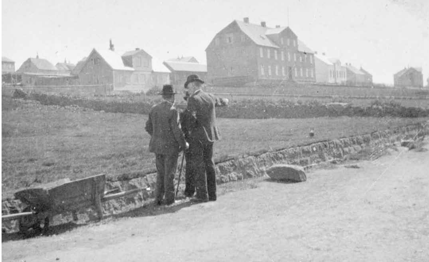
Lækjargata, Amtmannsstígur 1 sem var heimili Guðmundar Björnssonar í 40 ár, Menntaskólinn í Reykjavík, Íþaka, bókasafn MR. Ljósmynd: Christian Schierbeck læknir, 1901-1902. Undir myndina ritaði ljósmyndarinn: „Nefnd á vegum bæjarráðsins veltir öngum yfir stærsta rennustein bæjarins (sem stendur við hliðina á honum) – þessi svokallaði „lækur“ kostar þúsundir króna árlega. Það næst ekki nægjanlegur halli á frárennslinu. Litli herrann með stafinn, sem snýr baki, er héraðslæknir sem leiðbeindi mér. Hrokafullur karl sem gerir heimskuleg verkefni, lélegur biðraðalæknir.“ [Héraðslæknir í Reykjavík á þessum tíma var Guðmundur Björnsson]. Mynd Ljósmyndasafn Reykjavíkur.
