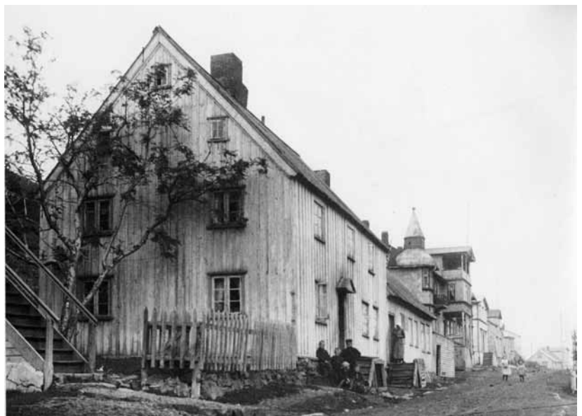
Aðalstræti 14 á Akureyri, fyrsta sjúkrahúsið á Akureyri (1873-1899). Líklegt er að þar hafi Jón Finsen læknir gert aðgerðir og meðal þeirra fyrstu aðgerðina á Íslandi þar sem svæfing var notuð. Sú aðgerð var á fimmtán ára stúlku árið 1856. Ljósmyndari: Hallgrímur Einarsson
