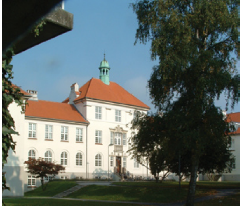
Ein af byggingum læknadeildar háskólans í Árósum.
